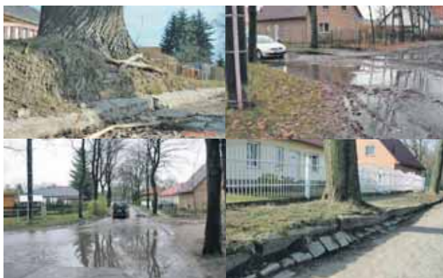
Die Situation ist für die Akteure der Schulwegsicherung unerträglich und sie fordern daher eine klare Abwägung.
